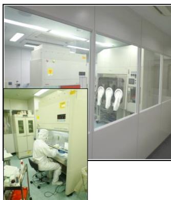
(クリーンルーム)
